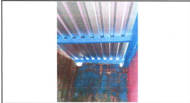
Foto1: CUBIERTA DE LÁMINA Y ESTRUCTURA DEL TECHO DE SANITARIOS NUEVA
