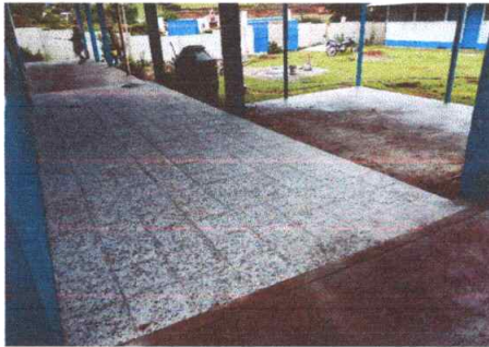
Foto 9: CORREDOR PRINCIPAL CON PISO NUEVO
