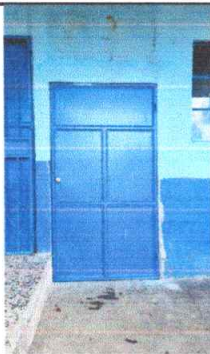
Foto 11: PASILLO CON LOSA DE PATIO NUEVA, Y SELLADO DE PARED
