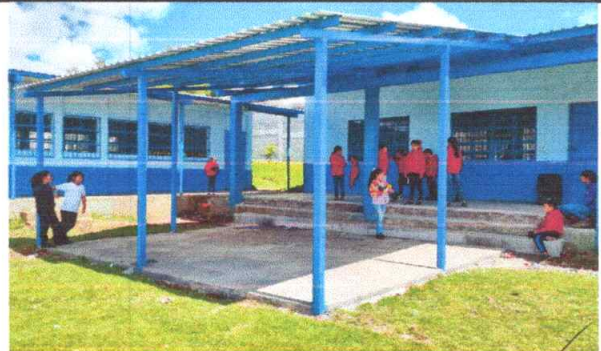
Foto 10: ESTRUCTURA Y TECHO DE GALERA PRINCIPAL.
