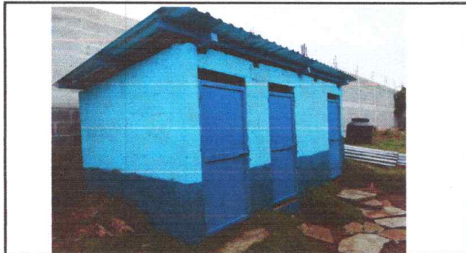
Foto 2: VISTA EXTERNA DE LA ESTRUCTURA DEL TECHO DE LOS SANITARIOS NUEVA
